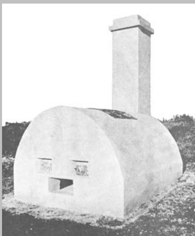
FOTO 20 - Incinerador de lixo
