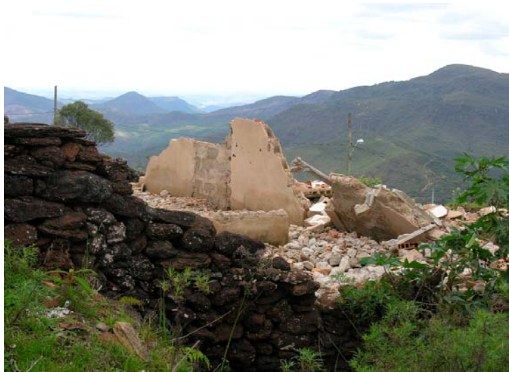
4. Demolição de obra irregular. Arquivo IPHAN.
