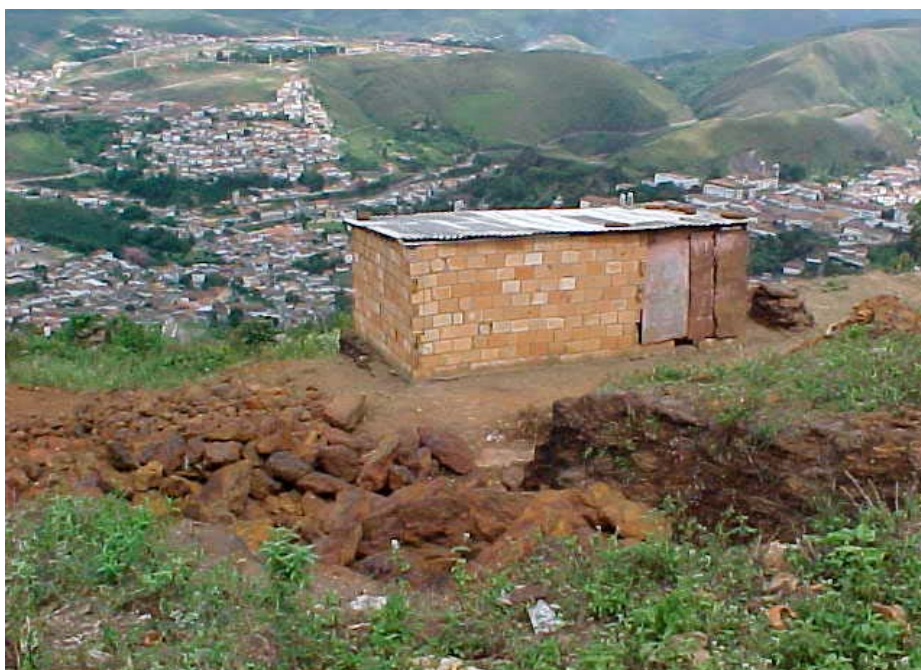
3. Obra irregular ao lado das ruínas. Arquivo IPHAN.
