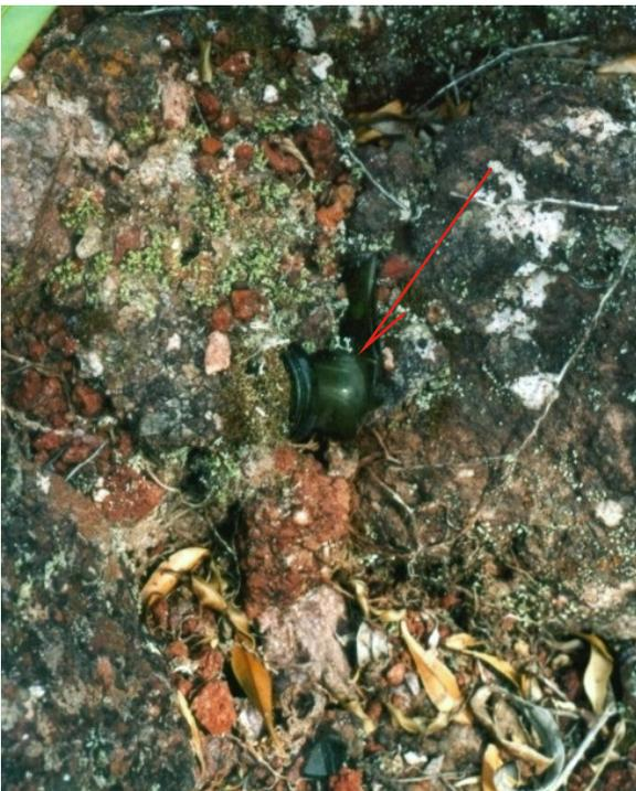
Foto 28 - Fragmento de vidro incrustado em argamassa de parede
